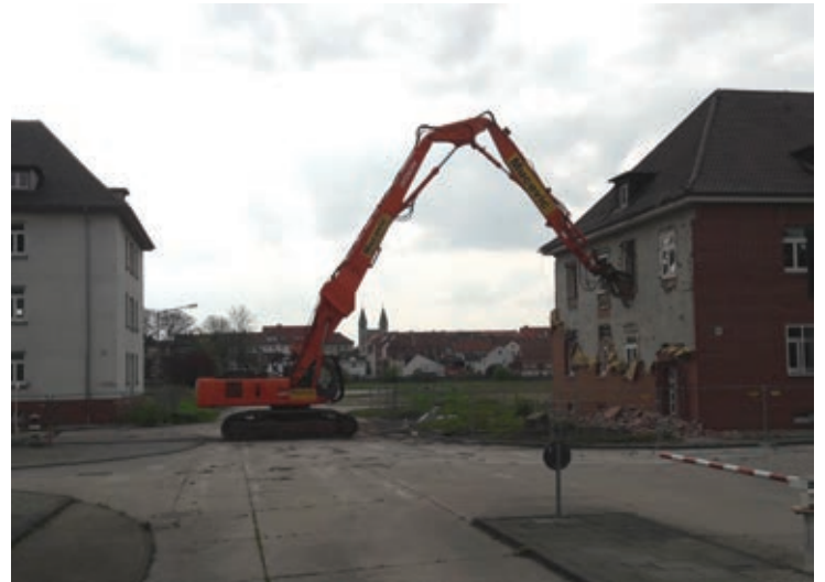
Bei den Abbrucharbeiten auf dem Mackensen-Areal kommt ein 45-Tonnen-Longfrontbagger zum Einsatz.
