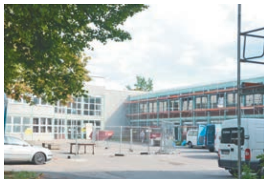
Blick vom Schulhof auf zwei Gebäudetrakte
