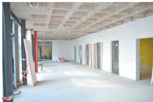
Fortschritt des Innenausbaus
