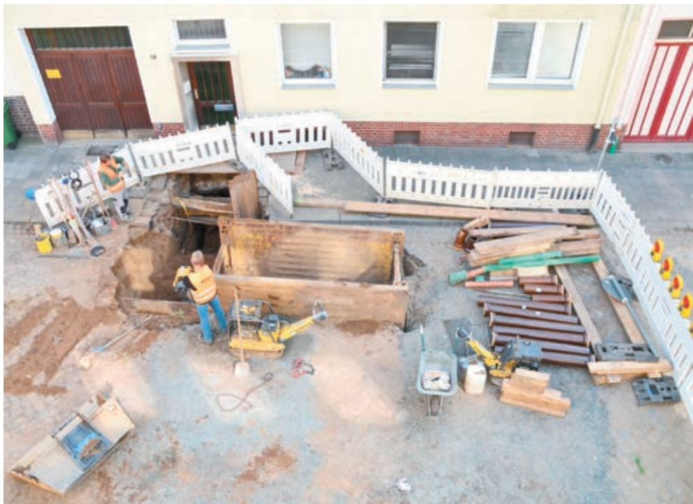
Blick von oben auf die laufenden Umbaumaßnahmen im Alten Markt
