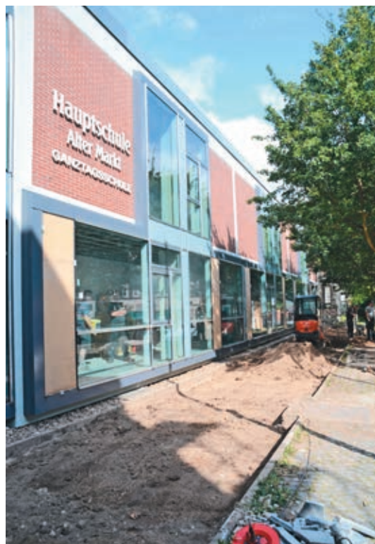
Arbeiten an der Gebäudehülle
