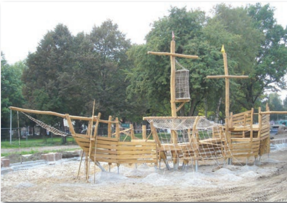
Baustelle Spielplatz: Endlich auch tolle, zeitgemäße Spielgeräte für die Kinder auf der Steingrube
