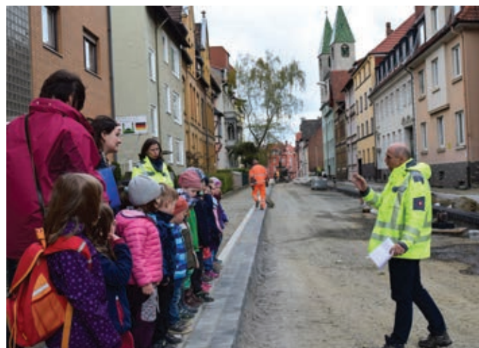
Bauleiter Holger Meisner erläuterte den Kindern die Abläufe auf der Baustelle (hinten Sabine Borgaes).
