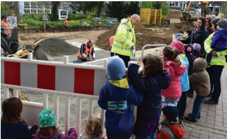
Bauleiter Holger Meisner erläuterte den Kindern die Abläufe auf der Baustelle.
