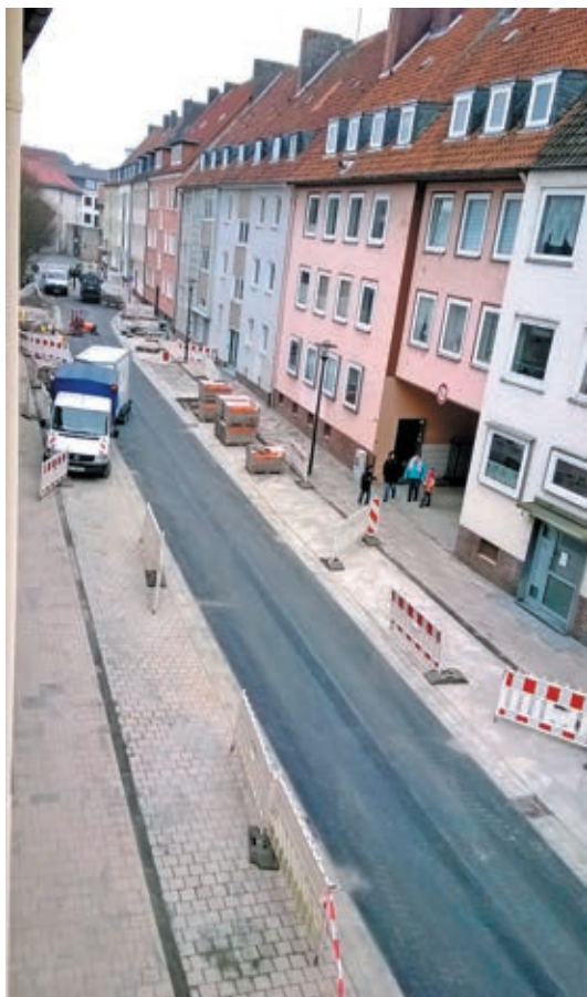
Bereits erfolgreich umgebaut: Alter Markt Ost
