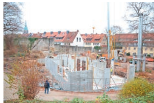
Baumaßnahme Kita St. Bernward
