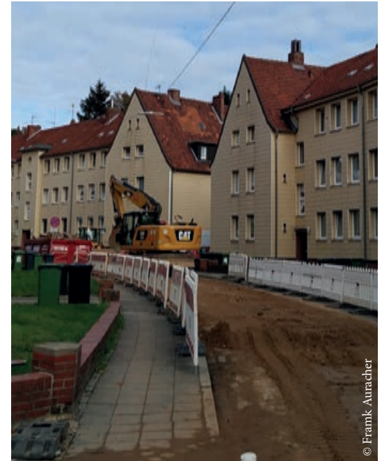
Foto der Bauarbeiten
