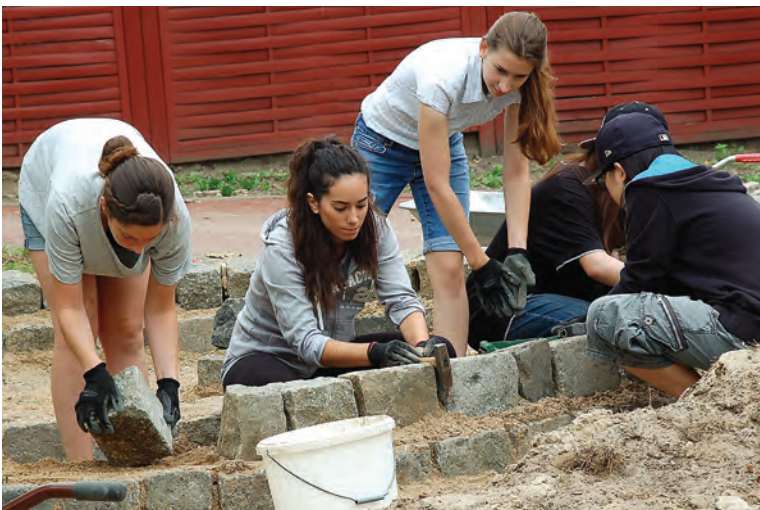
Bau der Kräuterspirale
