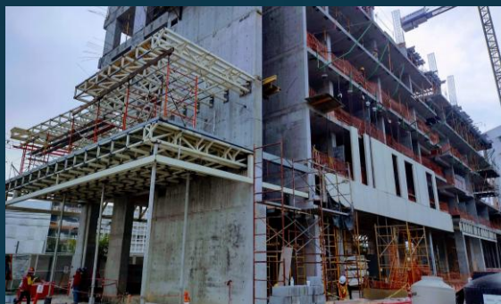
Construcción de cuartos de estudiantes para el Tecnológico de Monterrey, Monterrey Nuevo León
