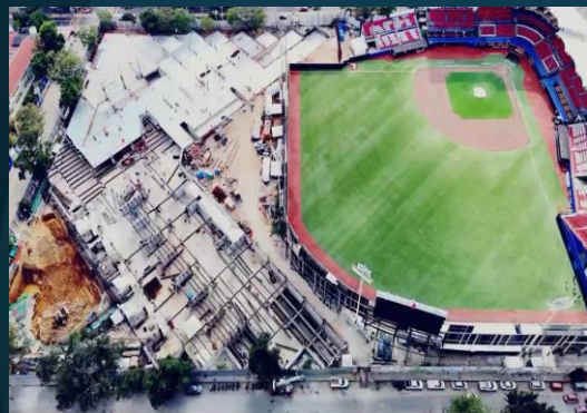
Construcción del Estadio de Beisbol de los Guerreros de Oaxaca, Oaxaca, Oaxaca de Juárez
