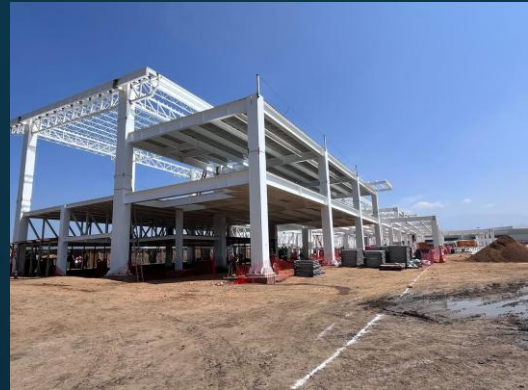
Construcción de del Aeropuerto Internacional de Oaxaca, Oaxaca, Oaxaca de Juárez
