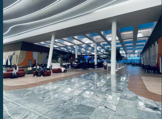
Construcción de última sala de espera "SUE" para el Aeropuerto Internacional de Guadalajara, Guadalajara, Jalisco
