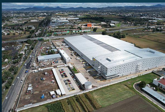
Construcción de centro de distribución de Coppel, Texcoco, Edo. De México
