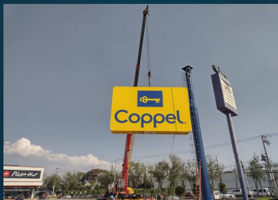
Montaje de Espectacular tipo paleta, Texcoco, Edo. De México
