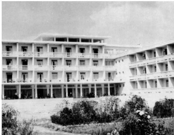
Maison de repos à l'intention des travailleurs.
