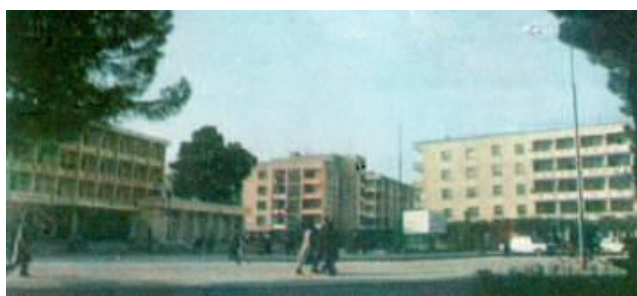
De nouvelles constructions à Fier
