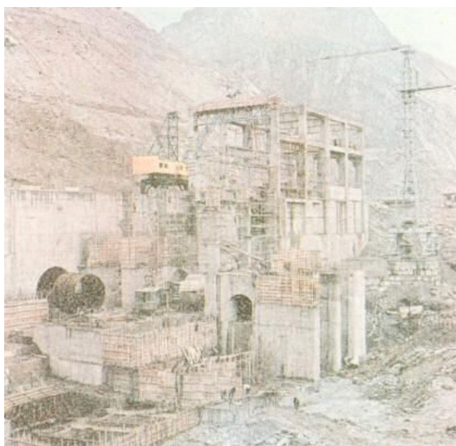
Vue de la centrale hydro-électrique «Enver Hoxha» de Koman en cours de construction
