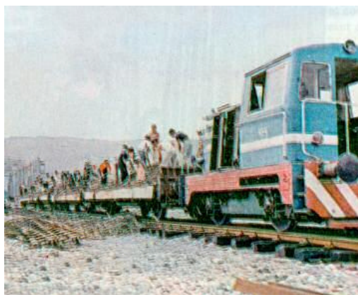
Etudiants travaillant à la construction de la voie ferrée Shköder-Hani i Hotit
