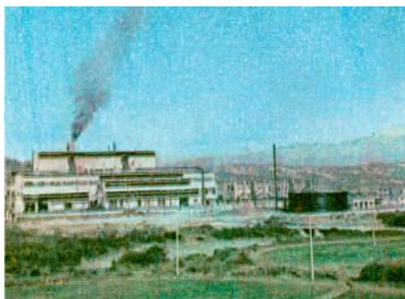
Vue de l'usine de ferrochrome de Burrel
