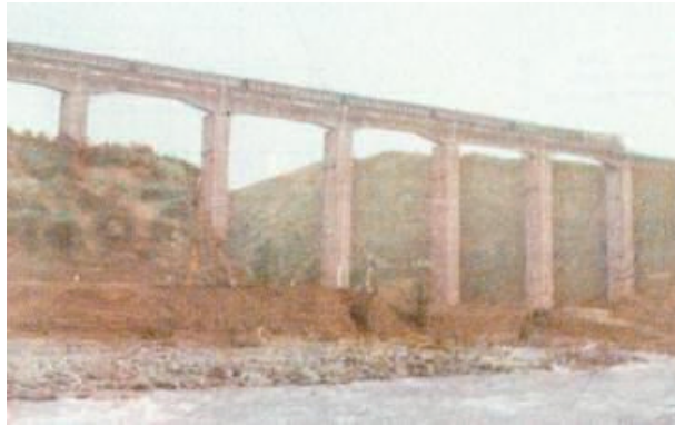
Vue de la voie ferrée Elbasan-Pogradec
