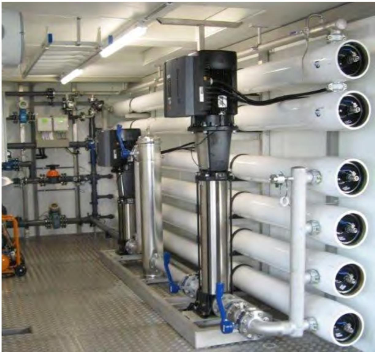
Fig 13: Installation de purification par osmose inverse (RO)
