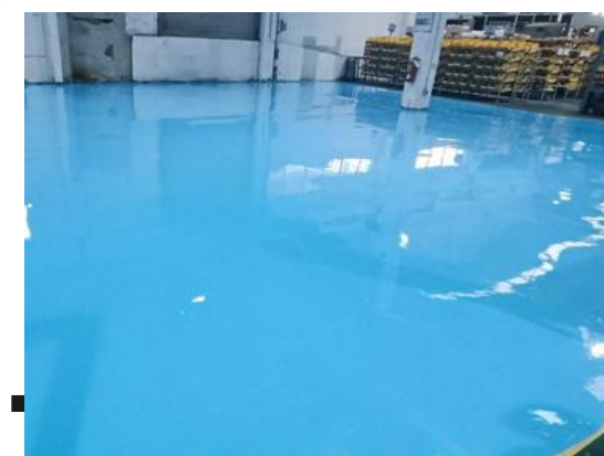
2023 PT. PAKOAKUINA, KARAWANG TIMUR - EPOXY FLOORING
