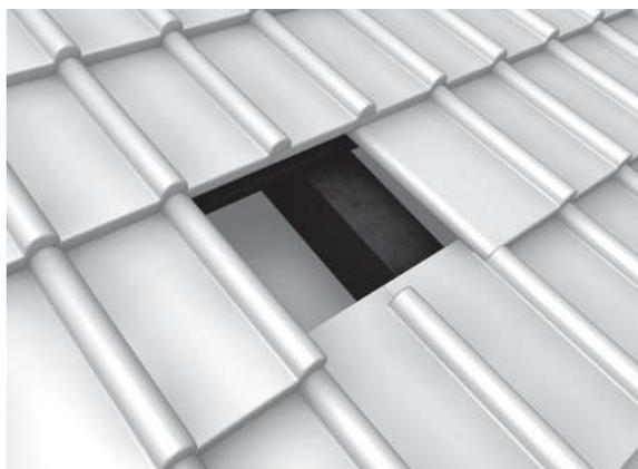
Il faut dégager les chevrons qui serviront à fixer les crochets. La hauteur du bras du crochet doit être vérifiée et réglée si nécessaire.
