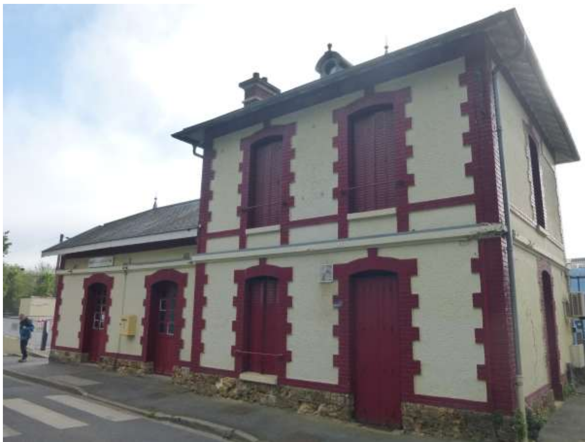
Gare de Maurecourt
