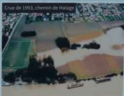
Crue de 1993, chemin de Halage
