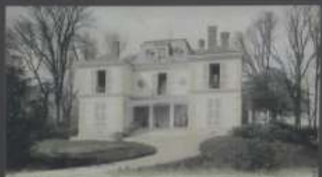
La grande demeure, construite au milieu de l'ancienne cour du château-fort.
