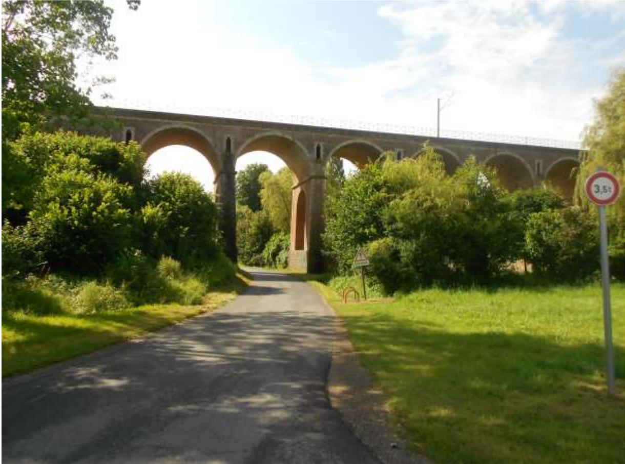
**De son vrai nom viaduc de l'Aubetin, petite rivière qui passe sous l'ouvrage, ou aussi appelé viaduc du Gué Plat, cet ouvrage en maçonnerie classique conçu pour deux voies et achevé en 1862 se distingue des autres ouvrages du même type par ses piles ajourées qui lui donnent un aspect de légèreté. En outre, son parement mixte composé de briques et pierres de taille, lui donne un aspect esthétique indéniable.**
