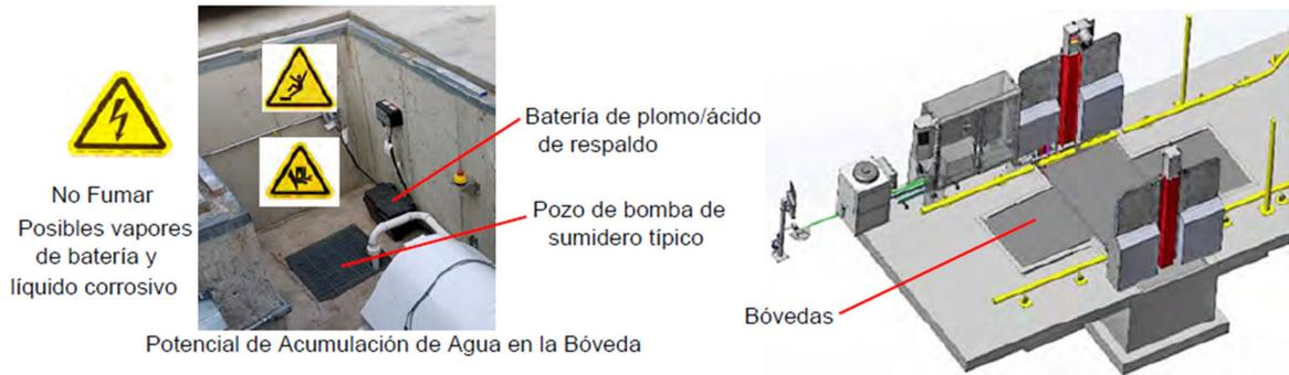
Figura 2-11: Sistema de Evacuación de Agua. Cámara de pozo rallado. Peligro de tropiezo o caída si la rejilla no está bien montada. Peligro de descarga eléctrica o electrocución si se acumula agua en la bóveda; apague todo el sistema antes de entrar. Se puede utilizar una batería de plomo/ácido de 12 V, peligro de humos nocivos e inflamables y fugas de líquidos corrosivos. No fumar en la bóveda.
