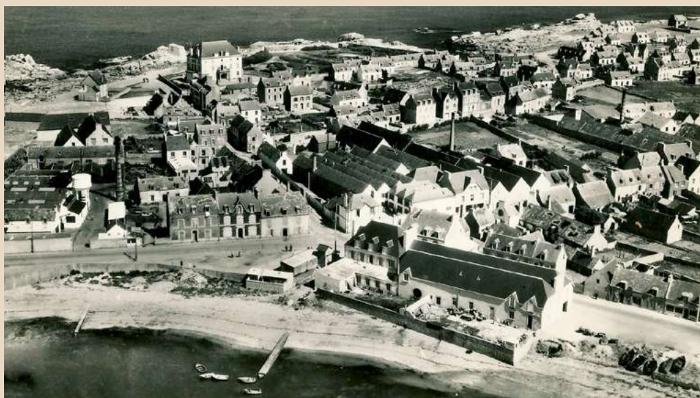
Au premier plan l'ancienne conserverie Ravilly, avant d'être transformée en fabrication de glace paillettes, qui deviendra par la suite notre restaurant (photo de 1953)
