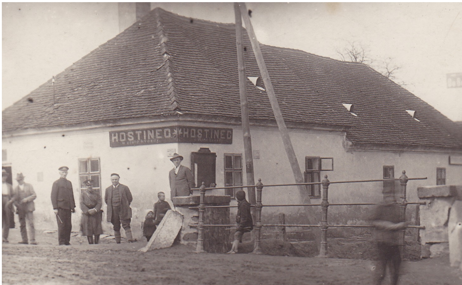
Místo pro stavbu bylo vytvořeno zbouráním obecní hospody U Zlaté hvězdy na Městečku č. 18.
