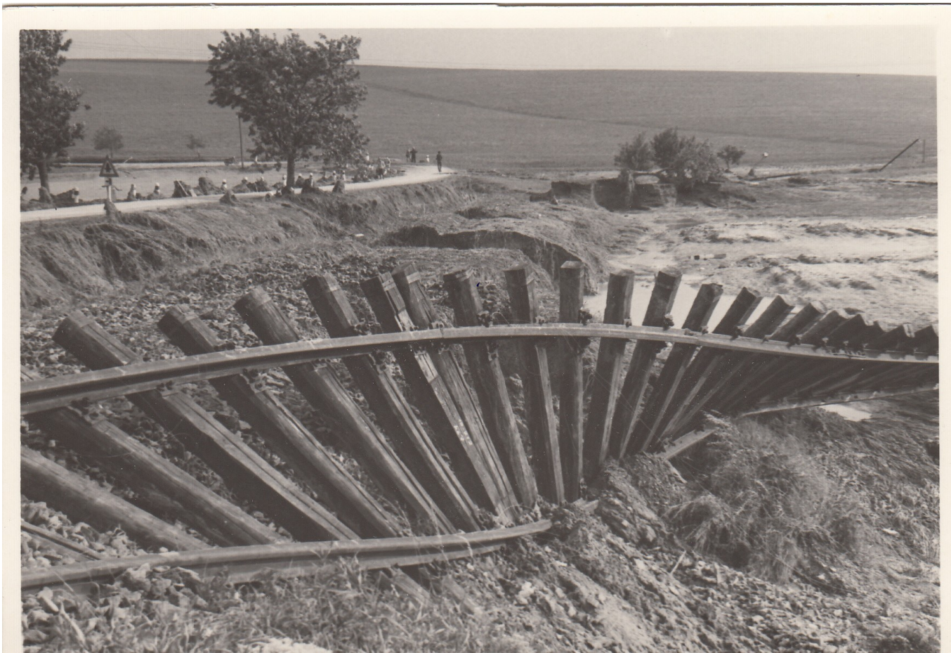
Železniční násep byl odplaven. Oba potoky ve Ždánicích se vylily
