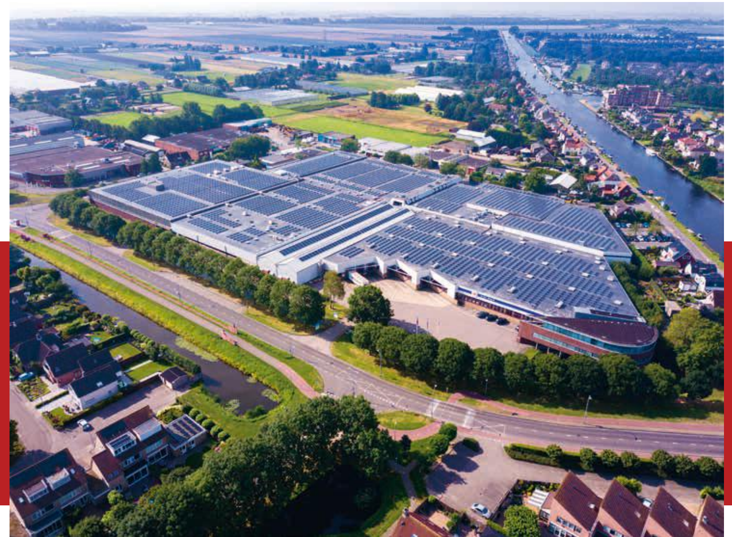
Van twee locaties van het Nederlandse bloembollenbedrijf Royal De Ree Holland in Lissebroek is het dak gerenoveerd. In nog geen vier maanden tijd is in totaal 33.000 m 2 dakoppervlak geïsoleerd, bedekt met Firestone's RubberGard EPDM dakbedekking en voorzien van 11.000 m 2 zonnepanelen. (Foto: ©Royal De Ree Holland bv)
