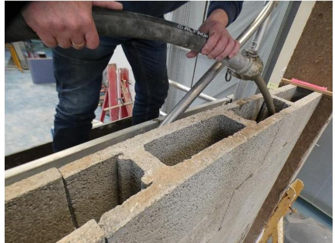
Vues du mur après mise en place de la totalité des blocs et du début du remplissage du noyau
