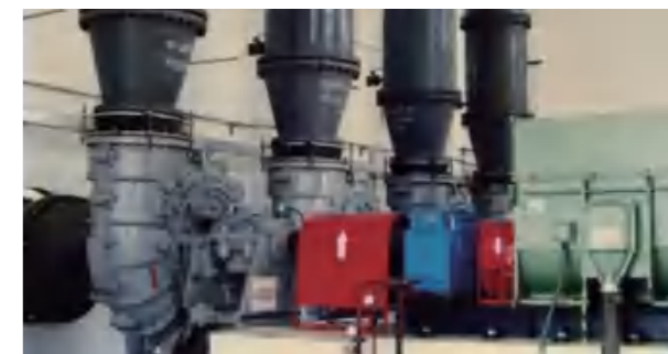
山东潍坊电厂 脱硫现场 Shandong Weifang Power Plant Project
