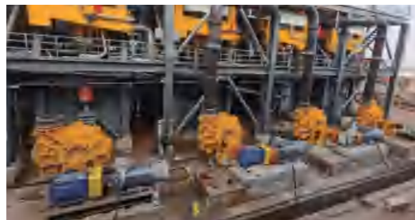
连云港矿山项目 Lianyungang mine project
