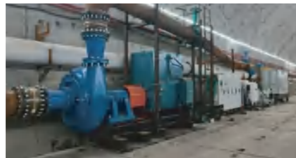
上海基础设施建设15米隧道项目 Shanghai Infrastructure 15m Tunnel Project
