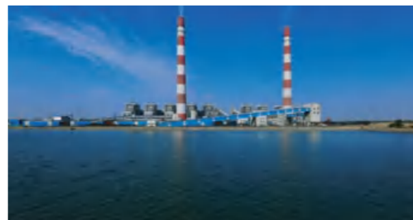
印度贾苏古达电站 脱硫项目 India Jasuguda Power Plant Desulfurization Project
