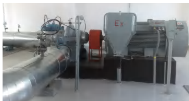
青岛油库输油泵项目 Qingdao oil depot oil delivery project
