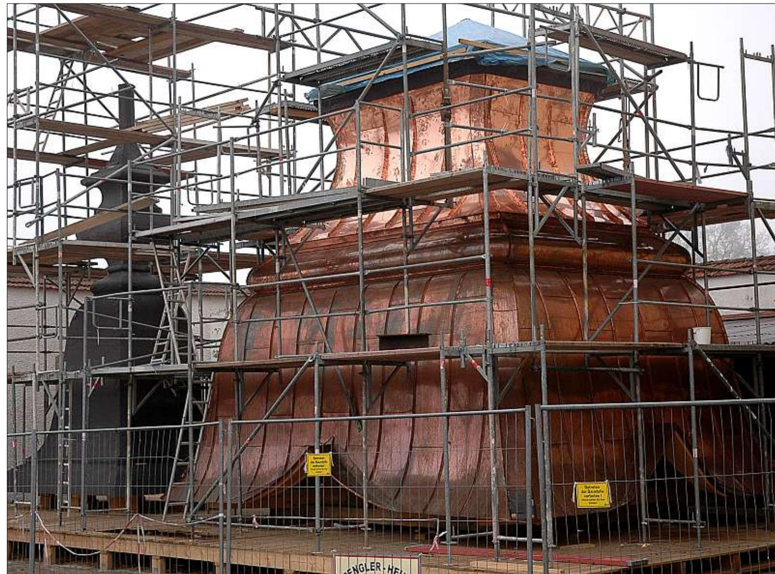
**Gefesselte Riesen:** Wie in einem Stützkorsett stehen Turmhelm und Turmspitze in den Gerüsten der Handwerker. Im Hof des Klosters arbeitet derzeit der Spengler an der Kupferhaut der Dachkonstruktion.
