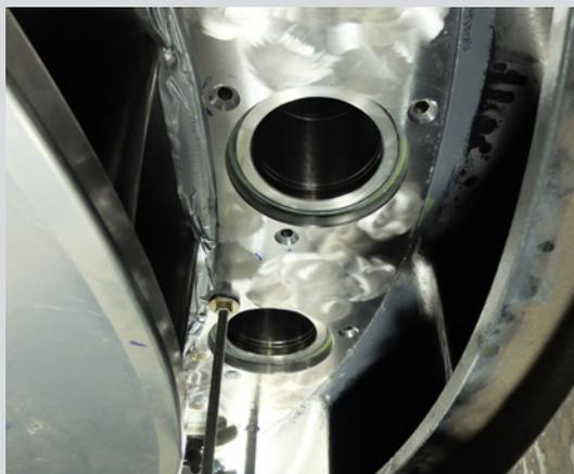
**Descripción:** Designación de los trabajos: mandrinado de 40 orificios para el paso de un diámetro de 213 mm a 217 mm en un entorno restringido.
