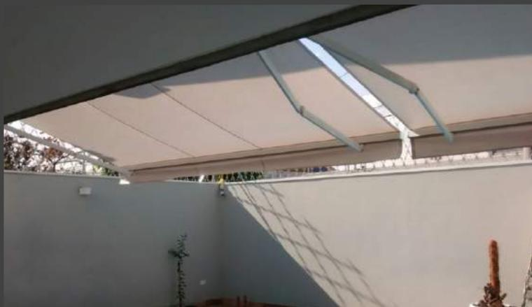
O toldo articulado standard é indicado para locais com menores dimensões. Sua fixação é feita através de suportes nas extremidades, que dispensa o uso da barra quadrada.
