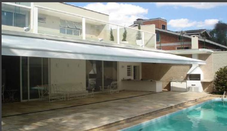
O toldo articulado flex é indicado para cobrir grandes áreas, com uma combinação especial de suportes e braços. A sua fixação é baseada em uma barra quadrada fixada à parede ou teto.
