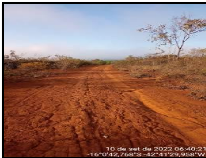
Figura 23: Acesso que será utilizado pelo empreendimento.
