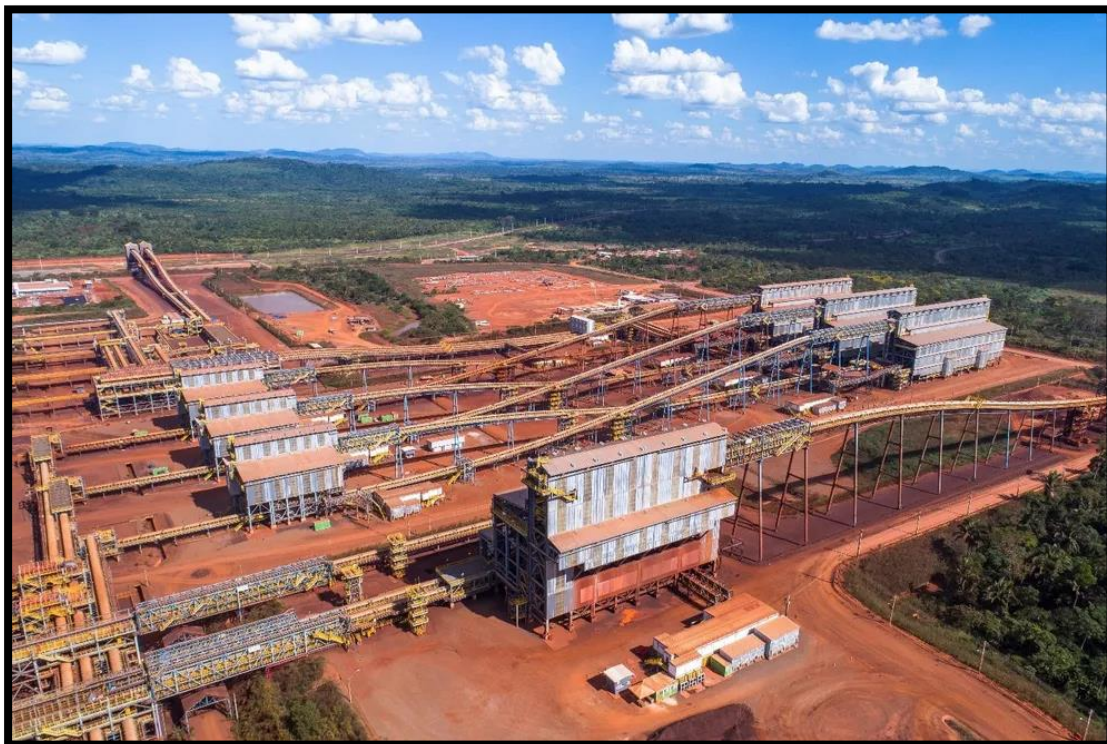
Foto 18: Usina de processamento de minério de ferro, no sudeste do Pará, que usa a mineração a seco
