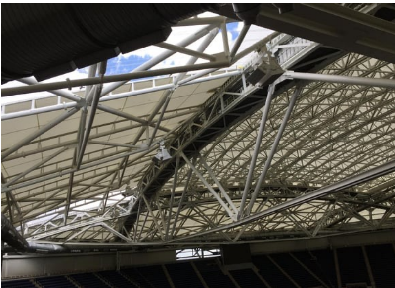
Cambio de sección en la cubierta del estadio de tenis Arthur Ashe en Flushing Meadows de Nueva York
