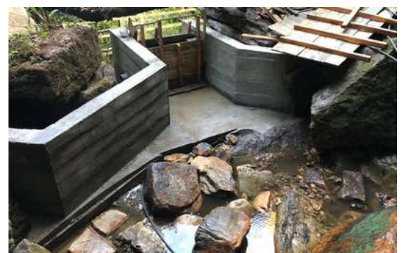
Construcción de Acueductos Vereda Tolima
