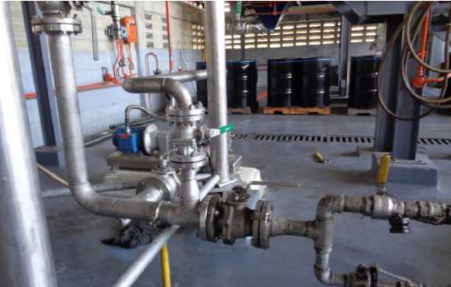
Obras para la instalación de bomba de recirculación. Cliente: Nalco Champion.
