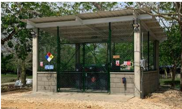
Construcción de caseta de combustibles Full Master GYPLAC.
