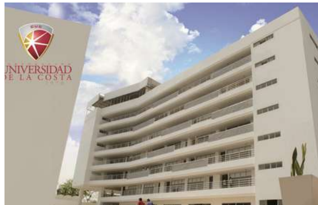
Diseño conceptual - Cogeneración. Sistema Generador: Motor gas natural. Capacidad: 1 MW. Cliente: CUC.
