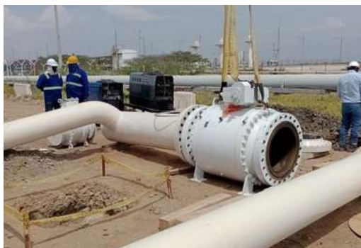
Obras metalmecánicas para construcción de Tie-In. Cliente: Massy energy - HOCOL.
