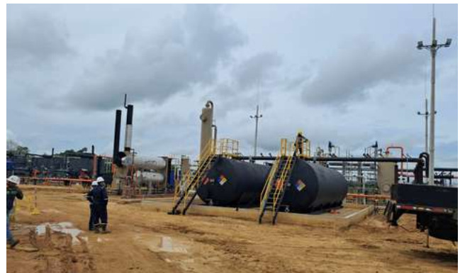
Suministro e instalacion de tanques. Cliente: Environ Services.
