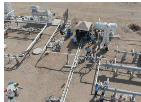
Construcción de CPF Maria Conchita.
