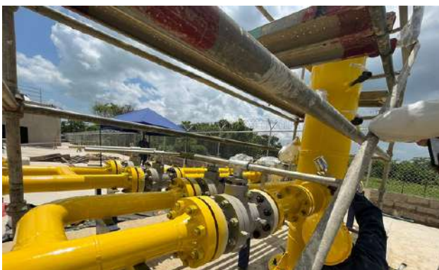
Construcción de Trenes de regulación para acometida de GAS.. Cliente: Termocaribe
