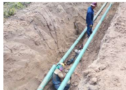
Ingeniería y construcción de gasoducto de 14 Km para interconexión de pozo Istambul y Aruchara y entrega de gas al SNT de TGI.
