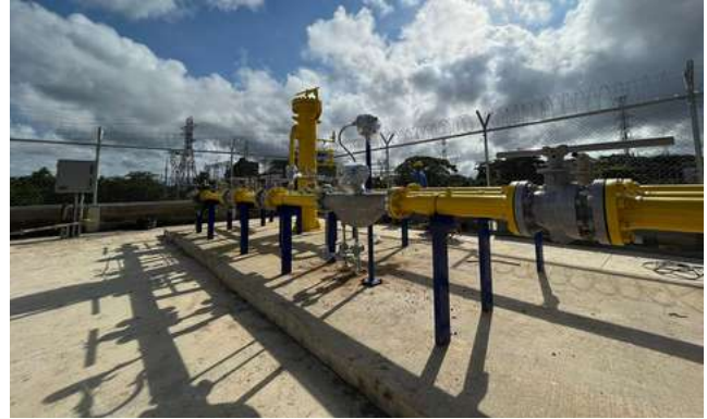
Construcción de ERM para acometida de Gas. Cliente: Termocaribe.
