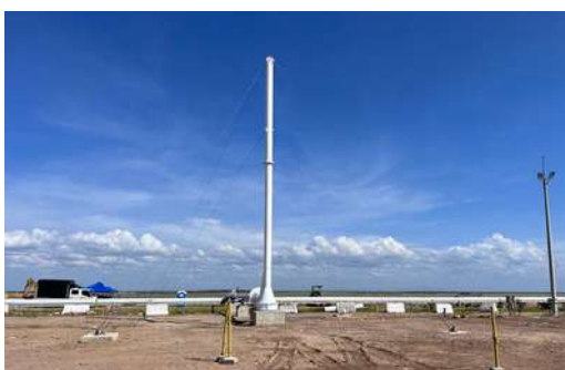
Suministro de Estaca de venteo en el complejo ballena. Cliente: HOCOL
