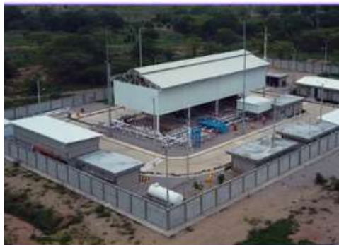
Diseño y Construcción de la Estación de Compresión La Paz. Cliente: Gases del Caribe.
