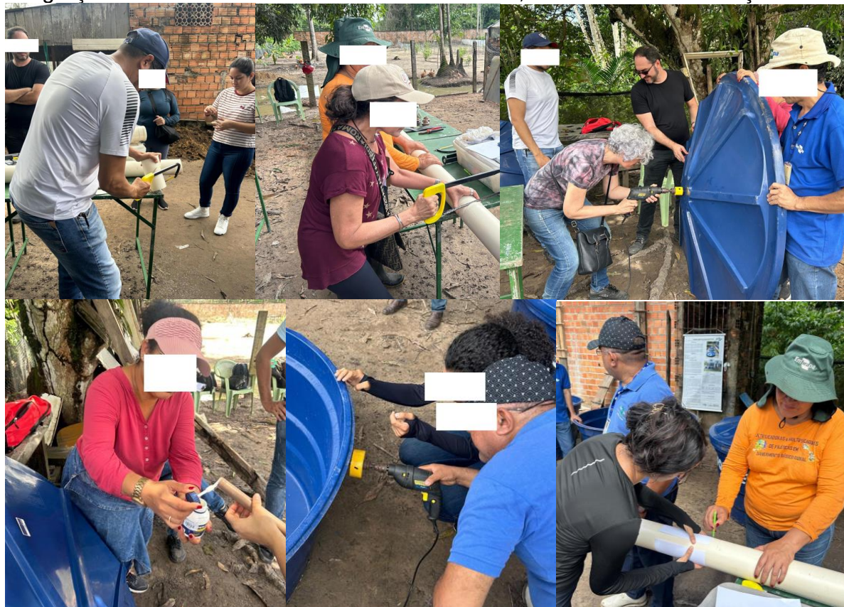
Figura 4 - Construção do sistema de fossa séptica biodigestora.
