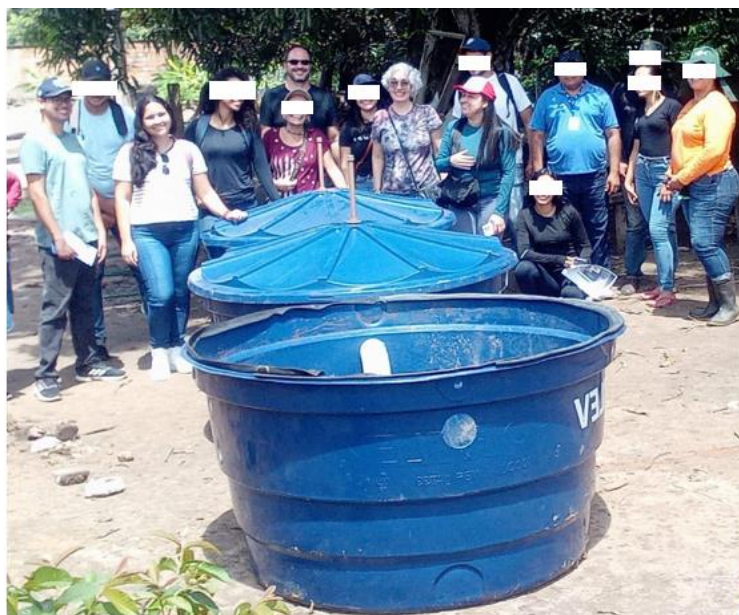
Figura 2 - Instalação da fossa biodigestora na casa do Sr. ABR.
