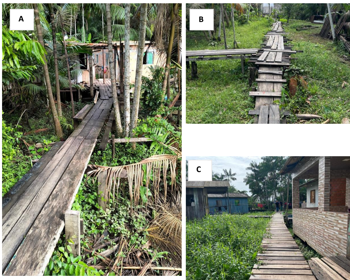
Figura 4 - A: Palafitas de madeira entre as residências; B: Desníveis e irregularidades nas madeiras presentes na estiva principal; C: Nova estrutura da estiva feita em um trecho na comunidade. Fonte: Autores.
