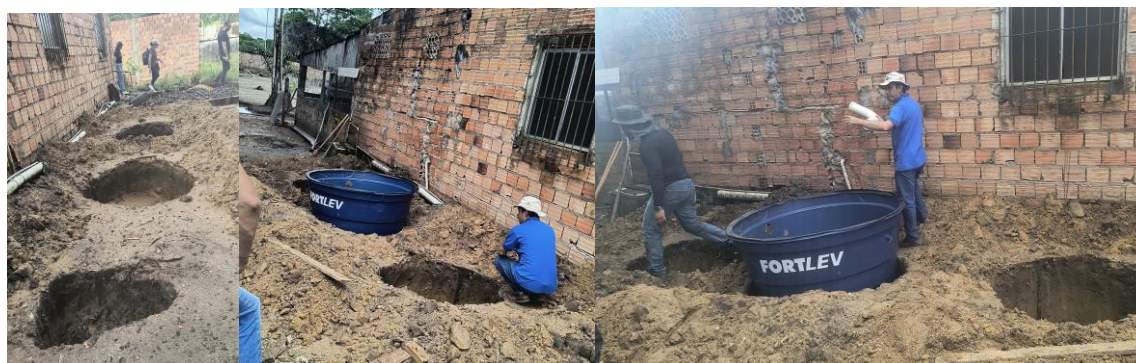
Figura 5 - Instalação do 2º do sistema de fossa séptica biodigestora.
