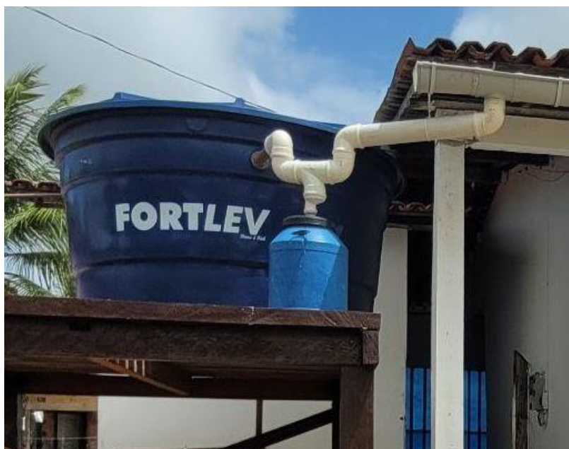
Figura 3: SAAC implantado na EMEIF Maria Ferreira Neves. Fonte: Autores
