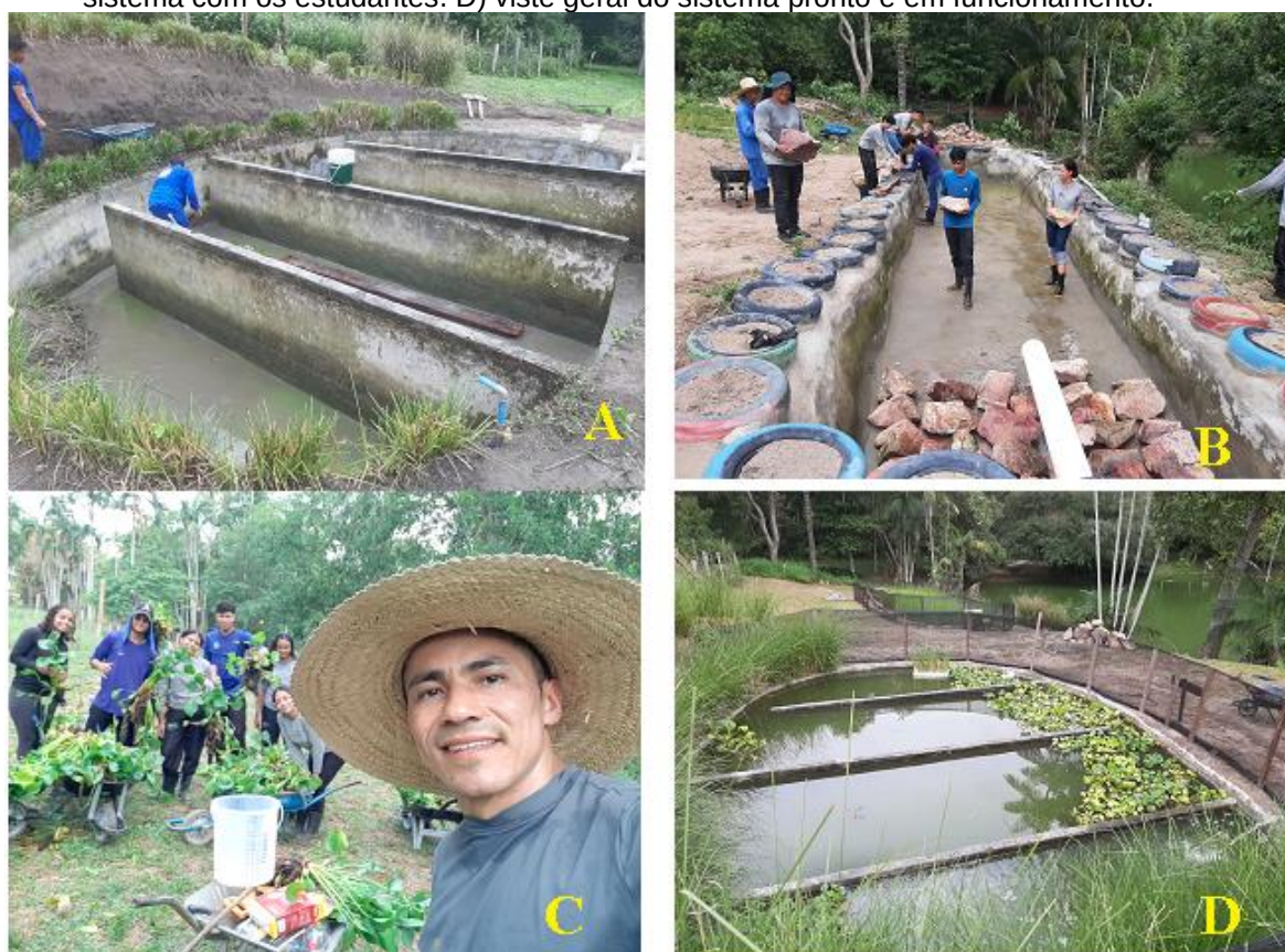
Figura 02: A) juste do wetland superficial. B) montagem do wetland subsuperficial. C) atividade de plantio do sistema com os estudantes. D) viste geral do sistema pronto e em funcionamento.
