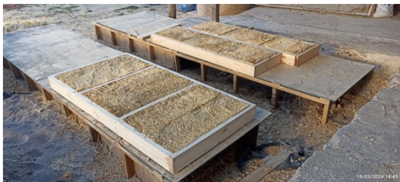
Figura 1. Estructura de un Cobijopanel.
