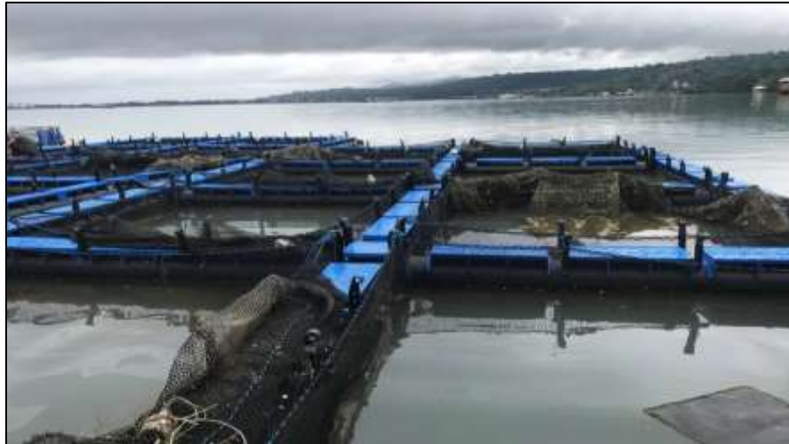
Gambar 2. Konstruksi KJA Berbahan Dasar HDPE
