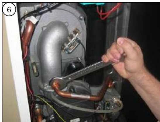
Démonter la canalisation gaz
