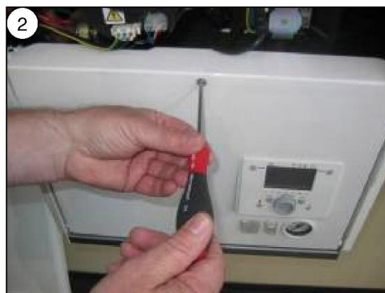
Basculer le tableau de bord de la chaudière pour pouvoir accéder au foyer
