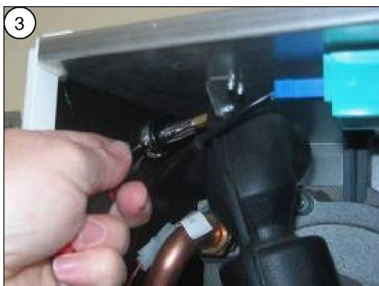
Démontage de la tuyauterie d'inspiration d'air
