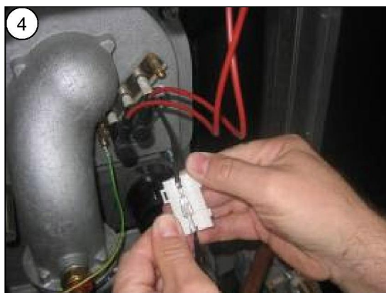
Déconnecter le câble de l'ionisation
