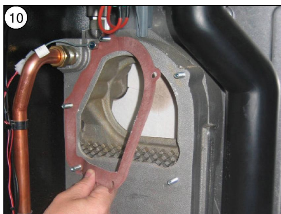
Enlever soigneusement le joint du brûleur
