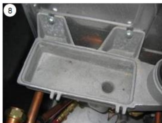
désaccoupler la boîte à fumer du corps de chauffe
