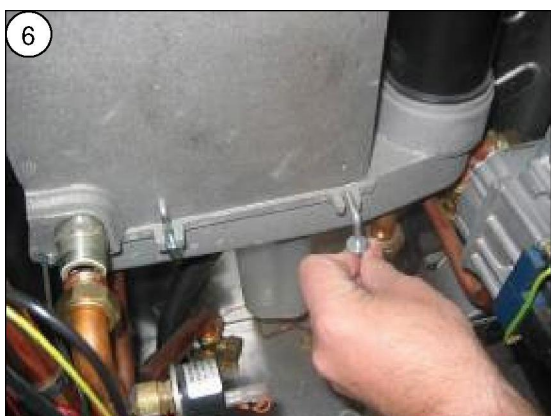
désaccoupler la boîte à fumer du corps de chauffe
