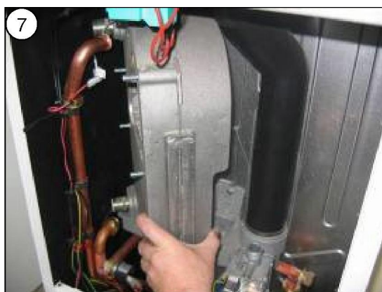
Sortir le corps de chauffe en le faisant pivoter a 45°
