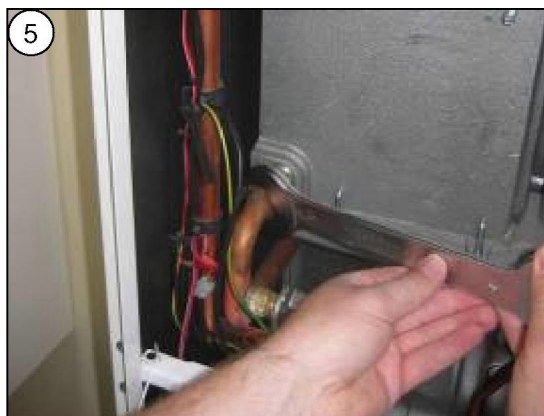
Démonter les tuyauteries départ retour d'eau du corps de chauffe chaudière
