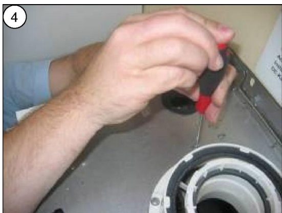
Démonter la fixation haute du corps de chauffe
