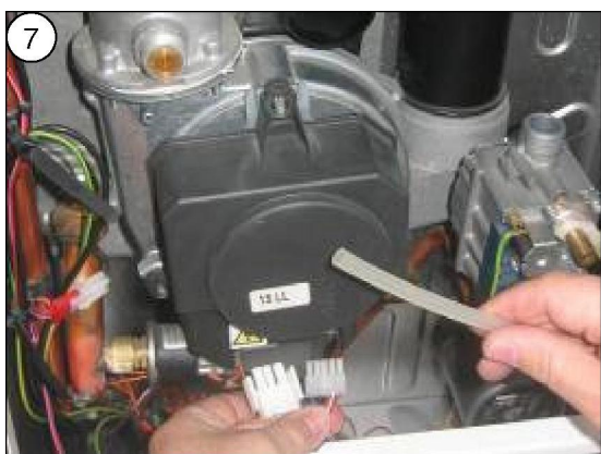
Déconnecter les câbles du ventilateur
