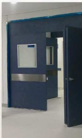
— PUERTA DE ACCESOS
