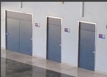
PUERTAS DE ACCESOS
