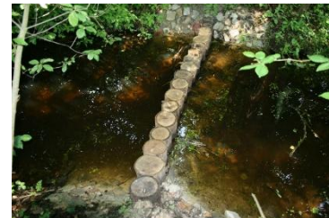
Próg spowalniający spływ wody
