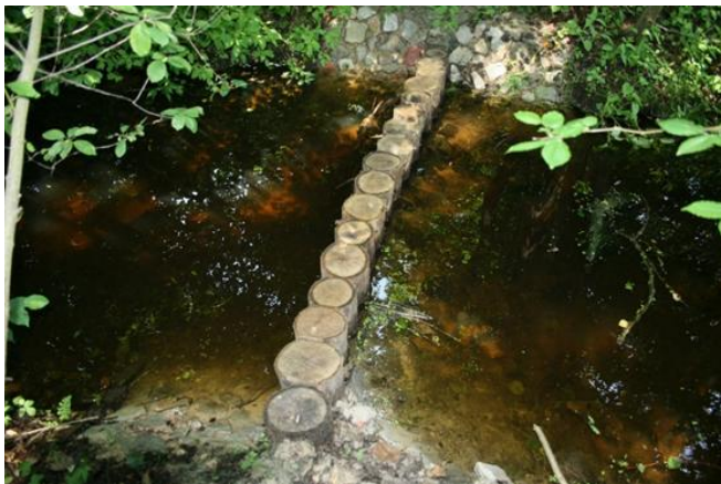
Próg spowalniający spływ wody
