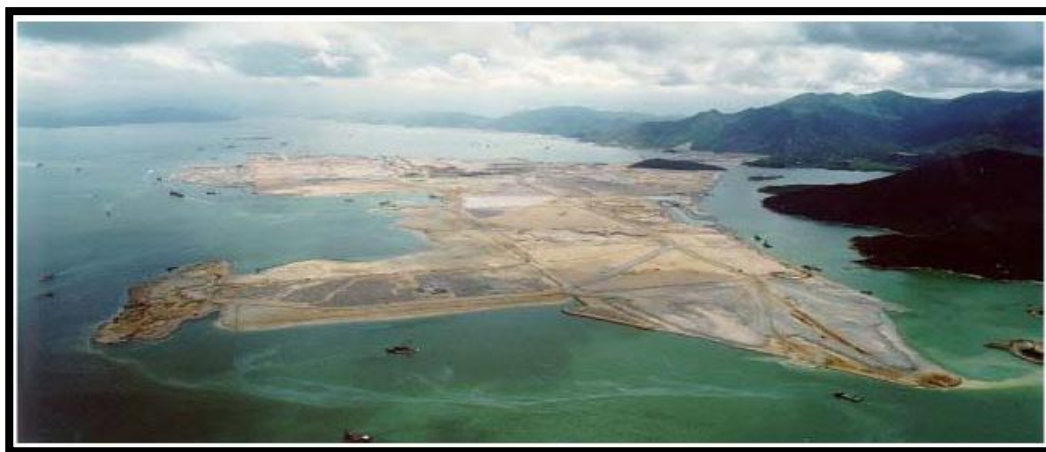
Figura 1. Construcción de la isla artificial ChekLapKok en Hong-Kong. (www.bnd.nl) Figure 1. Construction of artificial island ChekLapKok in Hong Kong. (www.bnd.nl)
