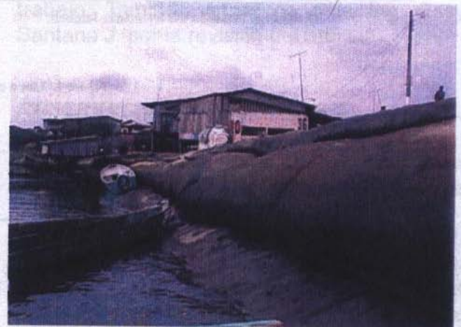
Foto 6.- Muro con geotubos en San Lorenzo (Provincia de Esmeraldas).
