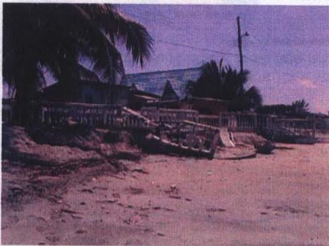
Foto 3.- Sector del Malecón con los Miradores destruidos. En este sector del Malecón, con 50 metros de largo por 15 metros de ancho, se concentró el mayor efecto de la erosión.
