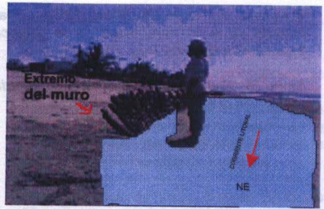
Foto 4.- La corriente litoral fluyó a lo largo del muro de estacas hasta donde éste terminaba.
