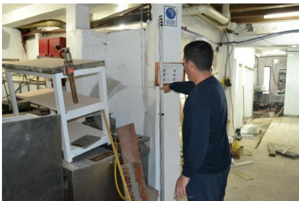
Figura 9 Línea de marca de agua sobre la pared de una vivienda en Puerto Ayora.
