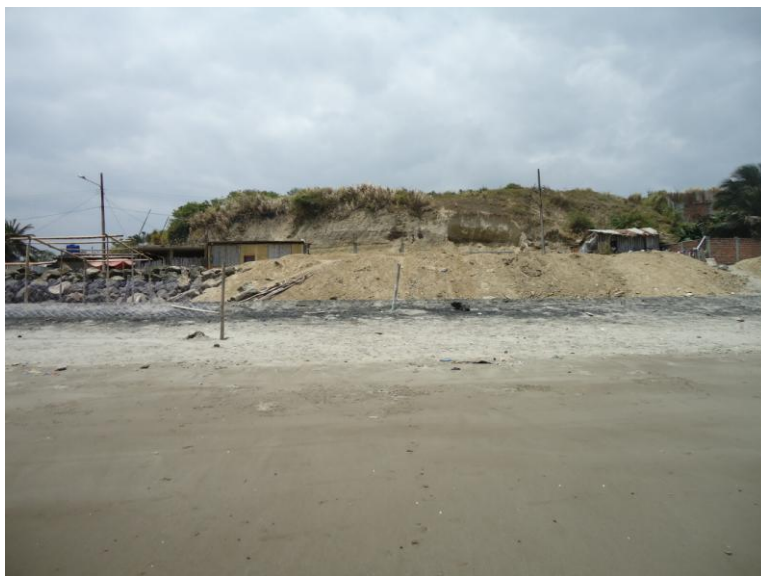
Foto 11.- Corte del acantilado para ampliar la superficie del terreno, y construir viviendas
