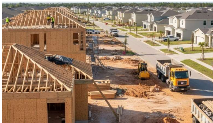
Canteiro de obras em Orlando, FL
