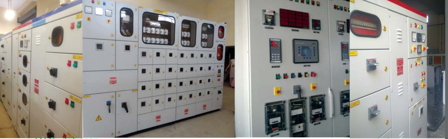
LV Switchgear
