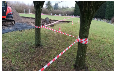
Absence de barrière Héras sur le chantier mais simplement de la rubalise
