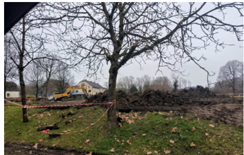
Absence de barrière Héras sur le chantier mais simplement de la rubalise
