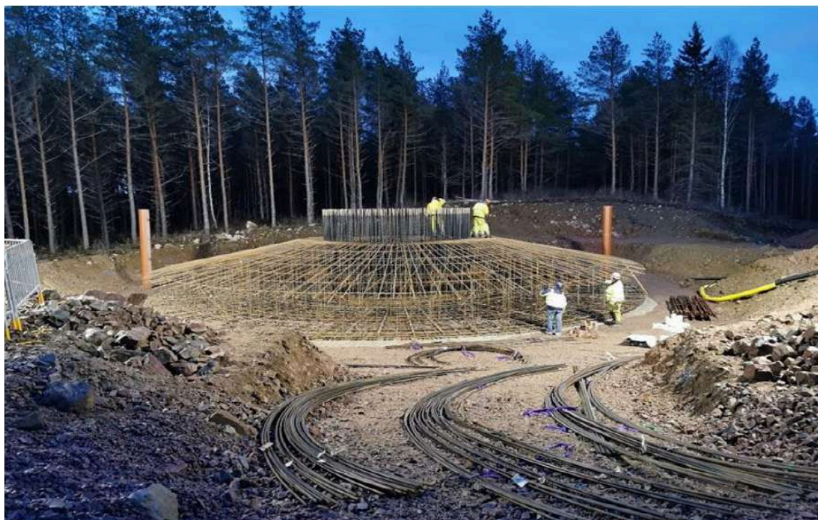
Figur 11 Gravitationsfundament i en av SR Energys vindparker. Källa: SR Energy.
