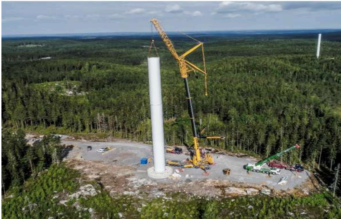
Bild 3. Vindkraftverk under uppbyggnad. Bild från SR Energy
