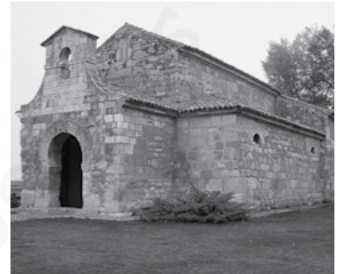
San Juan de Baños, siglo VII
