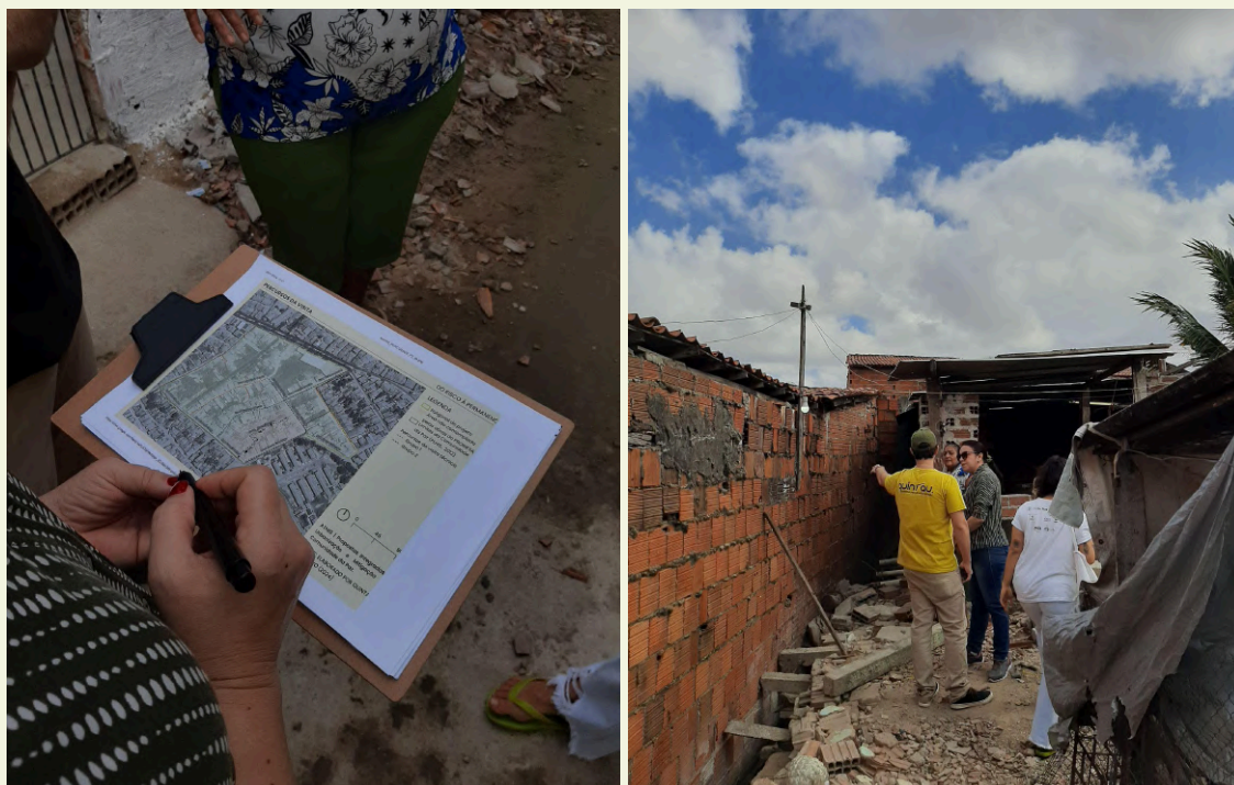
Figura 28. Registros da Visita Técnica
