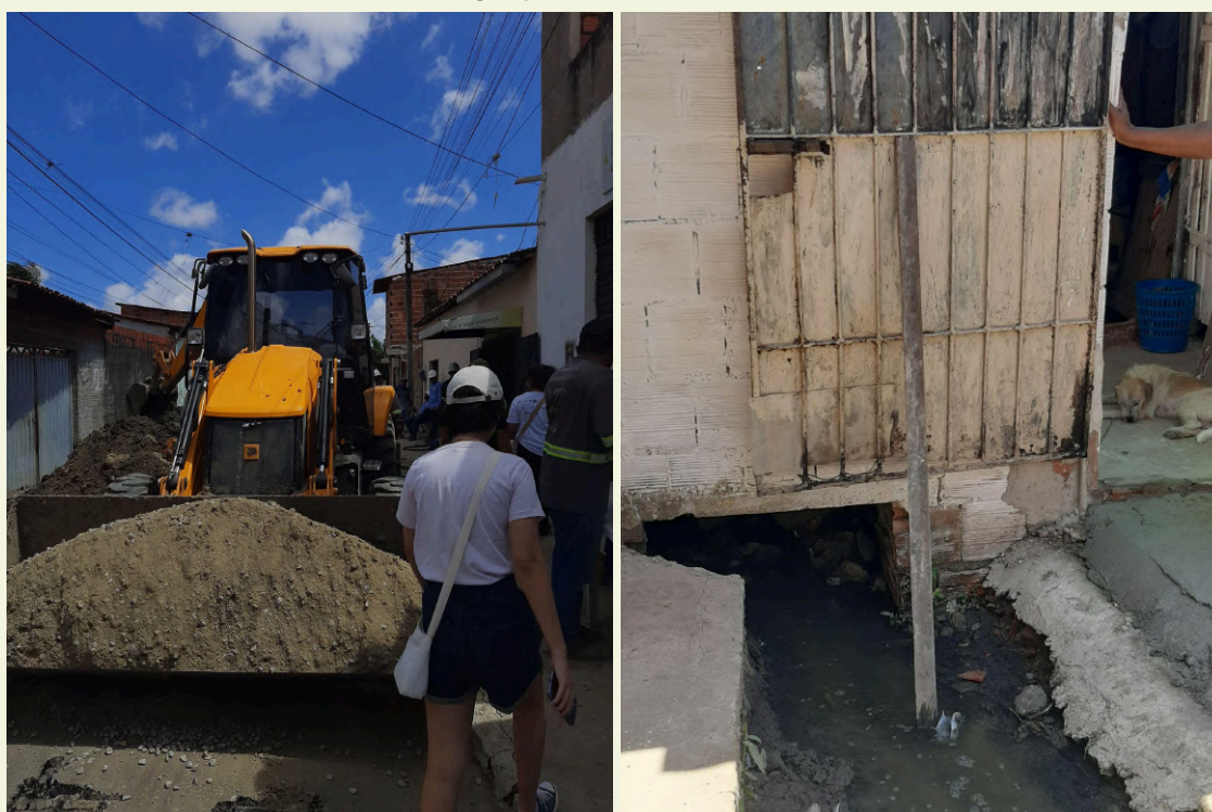
Figura 17. À esquerda, Rua Aguapé Verde em obras, e à direita, fio d'água passando abaixo da casa da moradora ao final da Travessa Aguapé Verde
