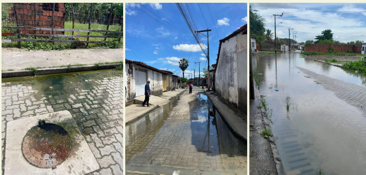
Figura 04. Imagens de Pontos de Alagamentos após obras do PROINFRA.
