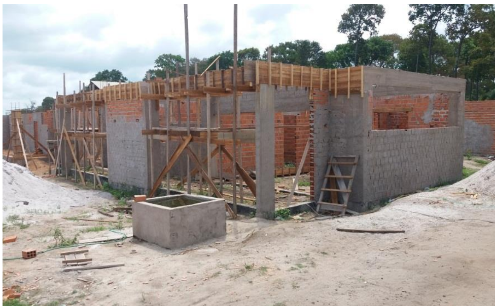
Imagem 11: Construção da Escola Pró-Infância da Comunidade Quilombola de Umarizal. Fonte: SANTOS, 2016.
