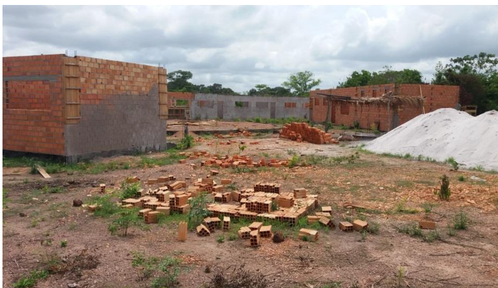
Imagem 12: Construção da Escola Técnica de Umarizal-Baião-Pará. Fonte: SANTOS, 2016.
