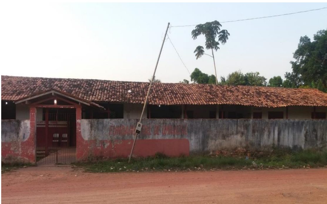
Imagem 10: Escola Municipal de Ensino Fundamental de Umarizal( Deolindo Melo). Fonte: SANTOS, 2016.
