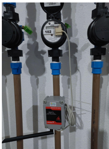
Figura 5: Exemplo de instalação do medidor SM-LA.
