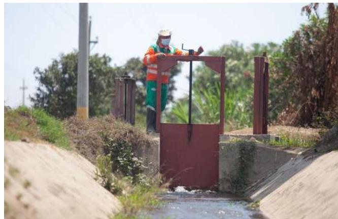
Se amplió la capacidad del reservorio Fortaleza. Entre las mejoras, se cambió las puertas metálicas que permiten el paso del agua de riego.
